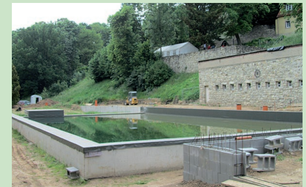
Der künftige Schwimmbereich, bereits mit Folie ausgelegt und mit Wasser befüllt. Im Hintergrund rechts das sanierungsbedürftige Duschgebäude im Mai 2011.
